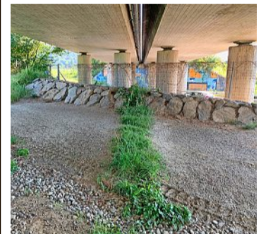
Unten der grüne Pflanzenstreifen, darüber der schmale Spalt, durch den das Regenwasser tropft.
